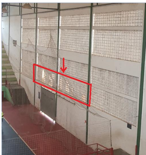
Figura 3 - Cobogós Danificados
