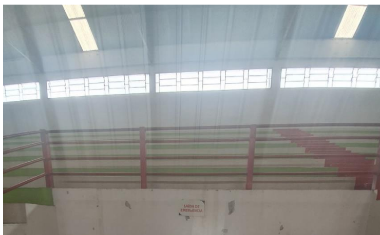
Figura 10 - Esquadrias do Ginásio Poliesportivo
