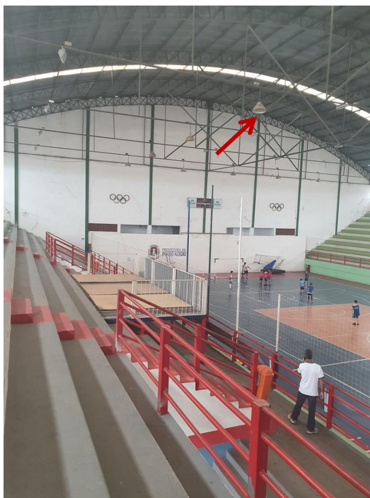
Figura 4 - Tipo de lâmpada da quadra a ser substituída
